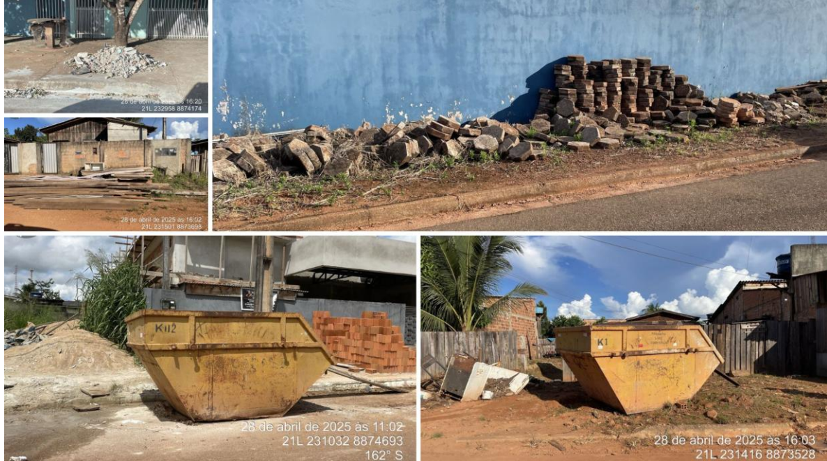
Figura 19. Registro Fotográfico Resíduos da Construção Civil (RCC) e volumosos.
