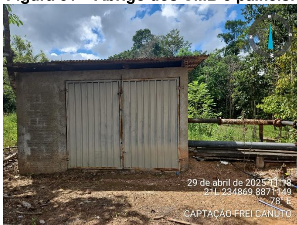
Figura 31 – Abrigo dos CMB e painéis.
