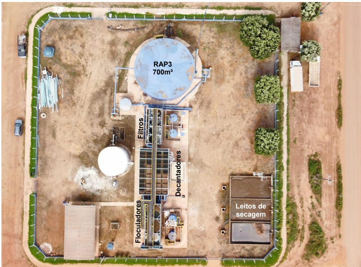
Figura 22 – Vista aérea da ETA Central.
