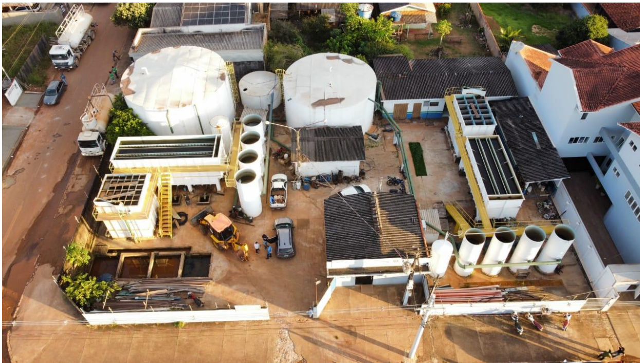
Figura 7 – Vista aérea da ETA Central.
