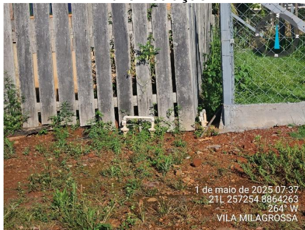
Figura 35 – Ligação predial sem hidrometração.
