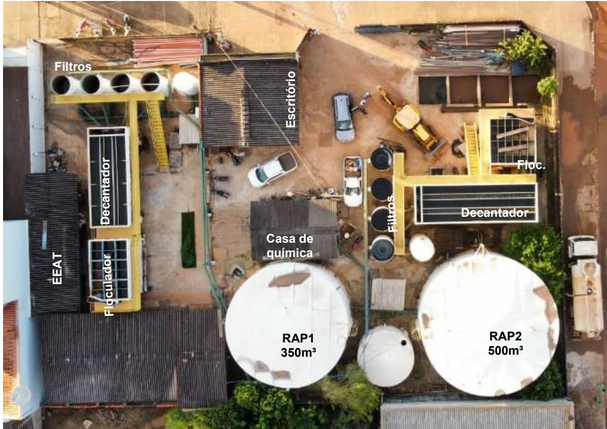
Figura 8 – Vista aérea da ETA Central.
