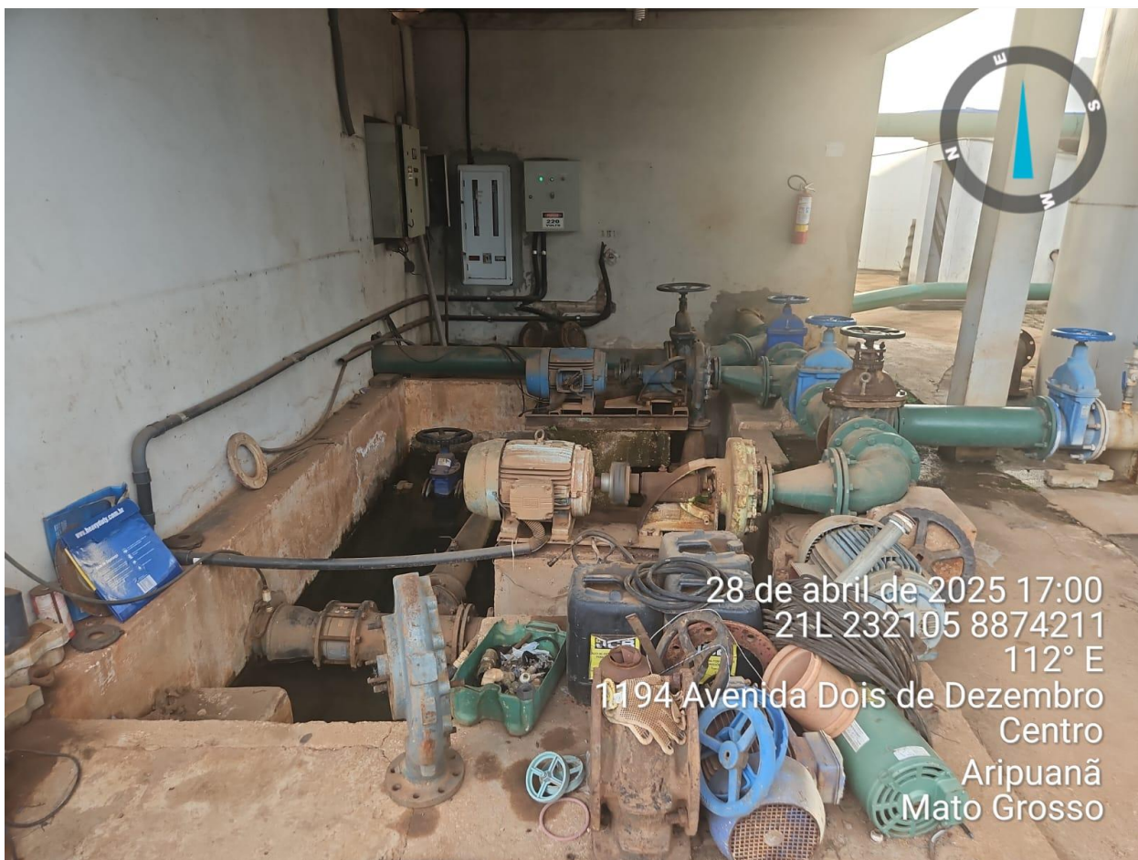
Figura 15 – Vista da EEAT 01 – Sistema Central.
