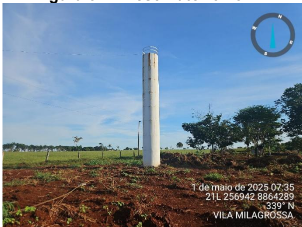
Figura 34 – Reservatório 15m³.
