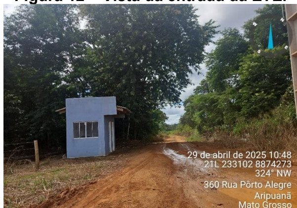
Figura 12 – Vista da entrada da ETE.
