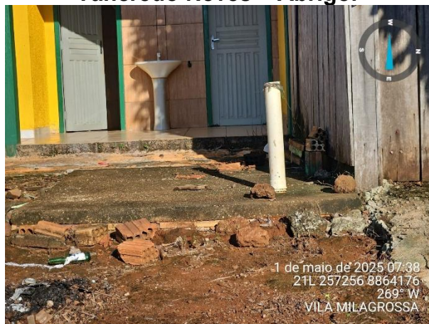
Figura 3 – EEE Av. Presidente Tancredo Neves – Abrigo.
