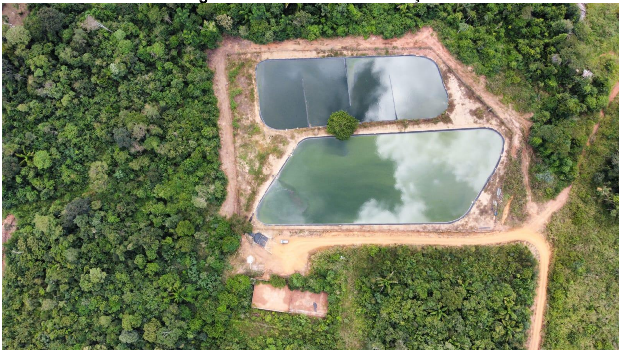
Figura 10 – Localização da ETE da Sede de Aripuanã – Tratamento Preliminar, Lagoas facultativa e de maturação.
