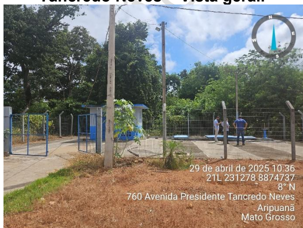
Figura 4 – EEE Av. Presidente Tancredo Neves – Vista geral.
