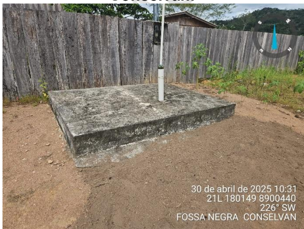
Figura 2 – Fossa existente – Distrito de Conselvan.
