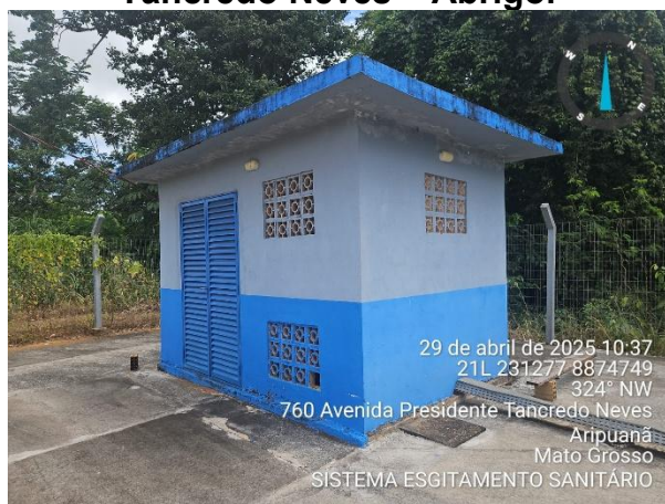
Figura 5 – EEE Av. Presidente Tancredo Neves – Abrigo.
