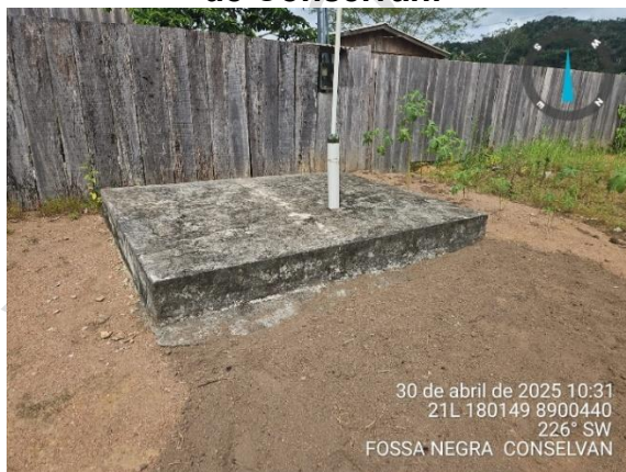
Figura 2 – Fossa existente – Distrito de Conselvan.
