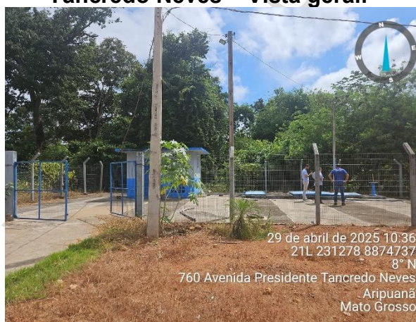
Figura 4 – EEE Av. Presidente Tancredo Neves – Vista geral.
