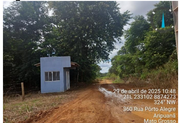
Figura 12 – Vista da entrada da ETE.
