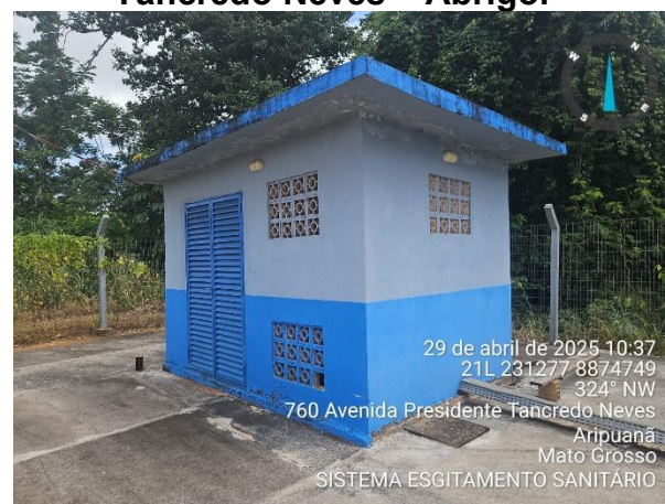
Figura 5 – EEE Av. Presidente Tancredo Neves – Abrigo.
