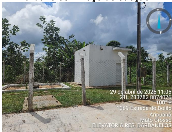
Figura 8 – EEE Residencial Dardanelos – Poço de sucção.
