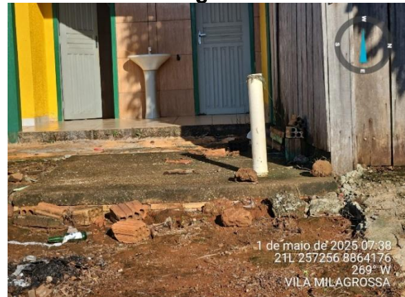
Figura 3 – Fossa existente – Vila Milagrosa.
