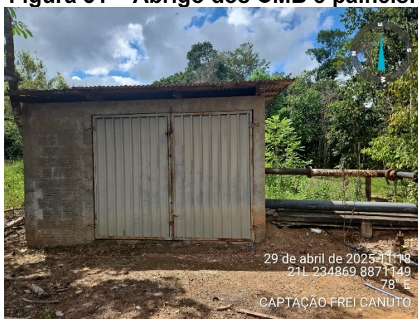
Figura 31 – Abrigo dos CMB e painéis.
