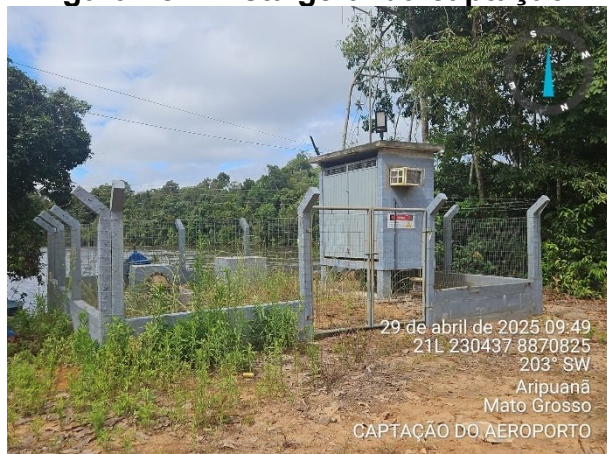
Figura 18 – Vista geral da captação.
