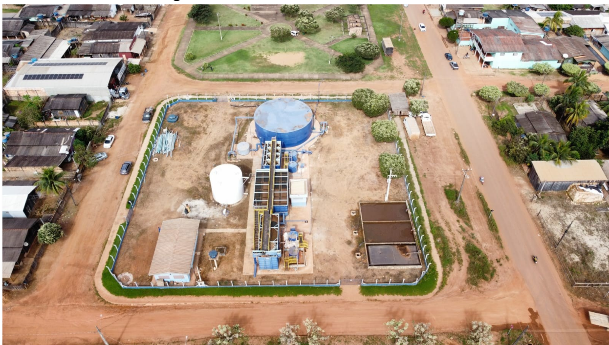
Figura 21 – Vista aérea da ETA Central.
