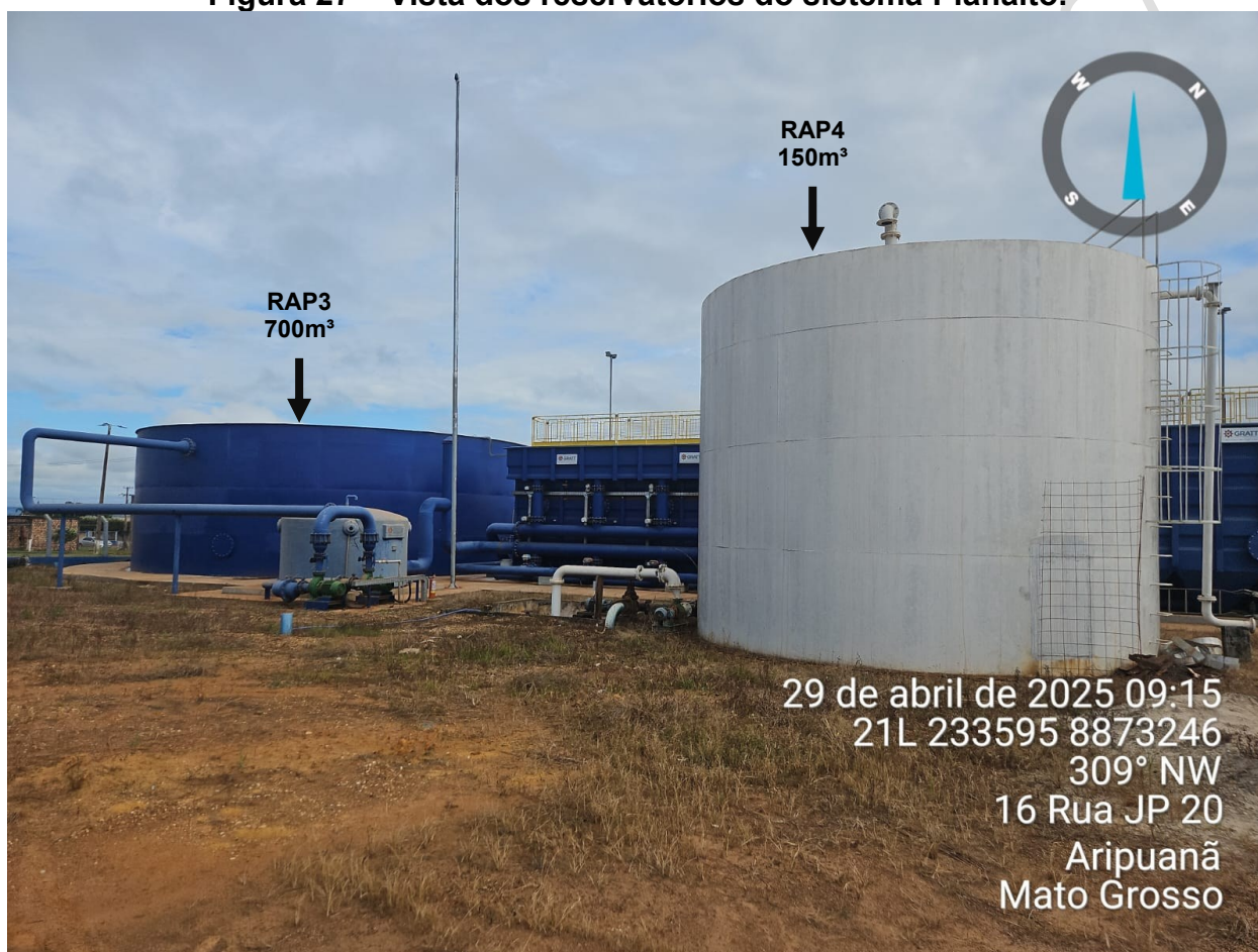
Figura 27 – Vista dos reservatórios do sistema Planalto.
