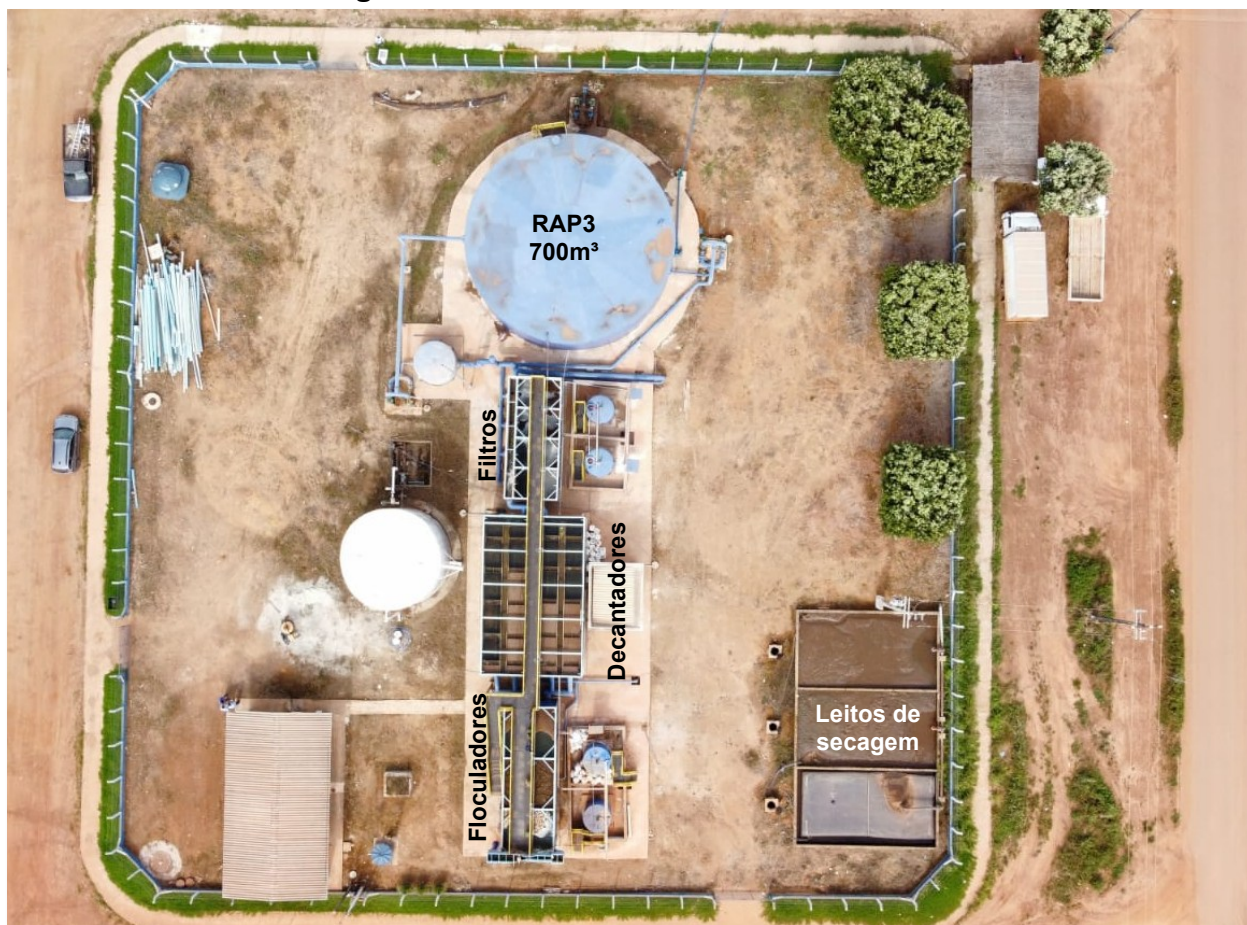
Figura 22 – Vista aérea da ETA Central.
