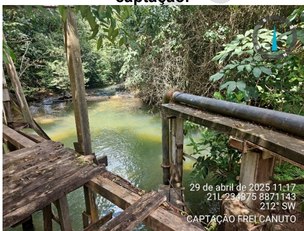
Figura 30 – Tomada direta da captação.
