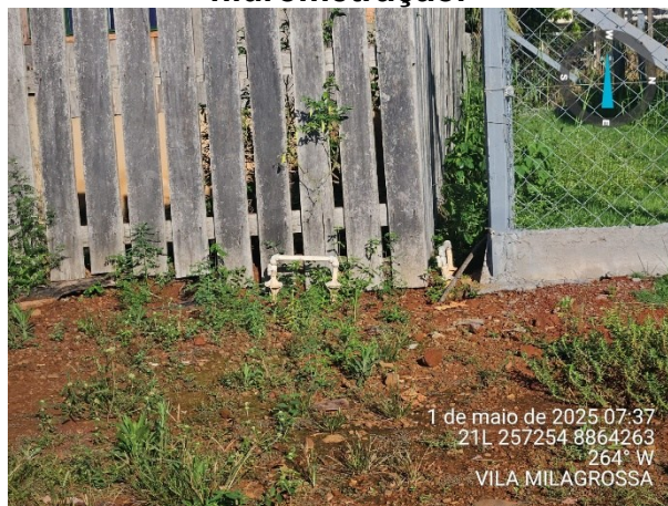
Figura 35 – Ligação predial sem hidrometração.
