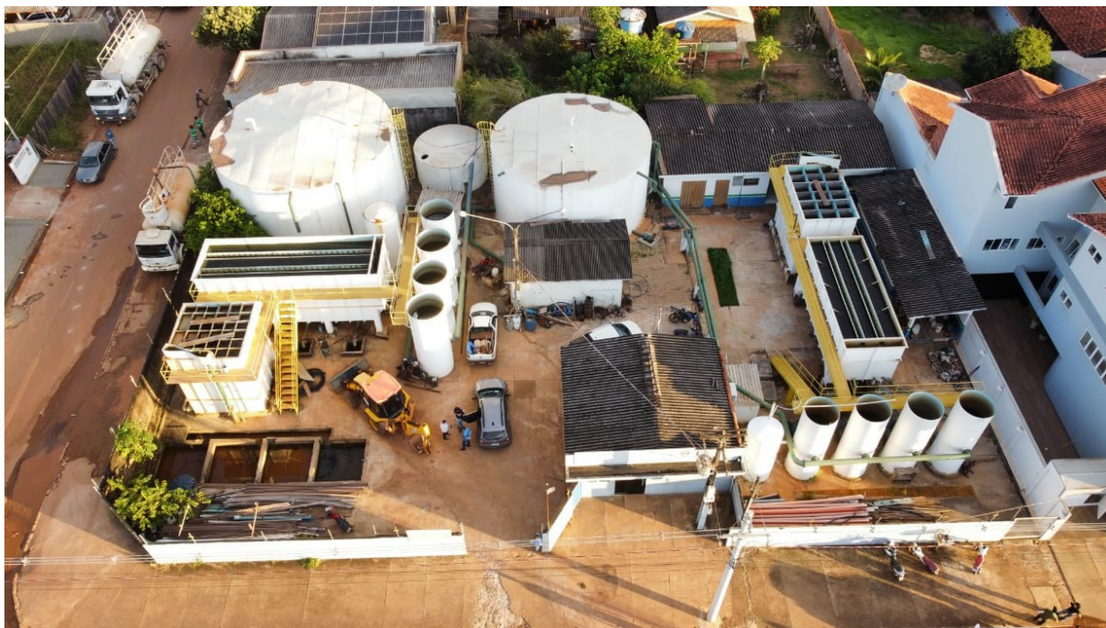
Figura 7 – Vista aérea da ETA Central.
