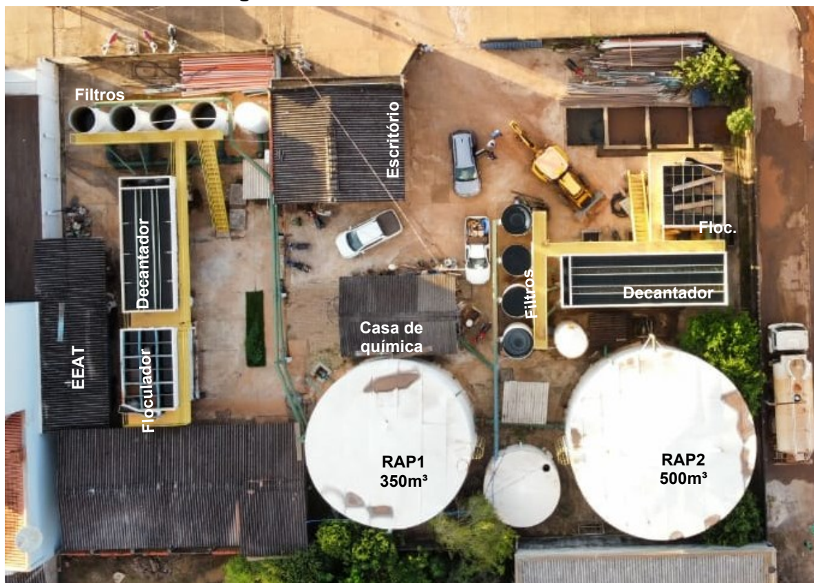
Figura 8 – Vista aérea da ETA Central.
