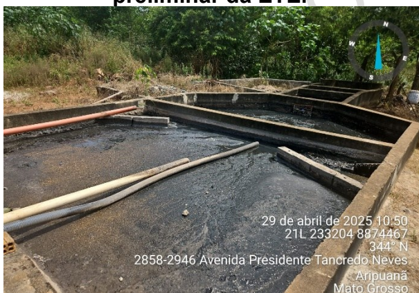
Figura 11 – Vista do tratamento preliminar da ETE.
