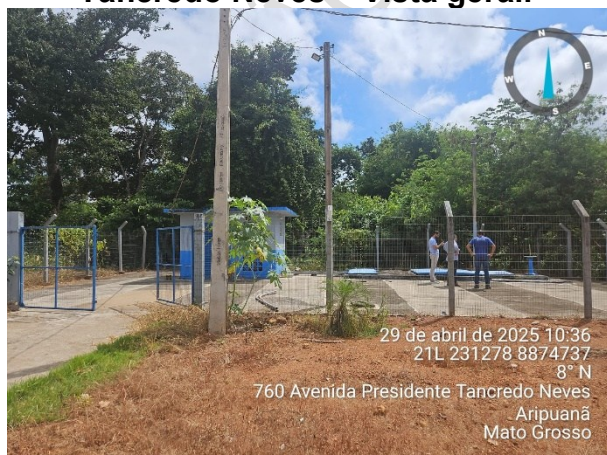
Figura 4 – EEE Av. Presidente Tancredo Neves – Vista geral.
