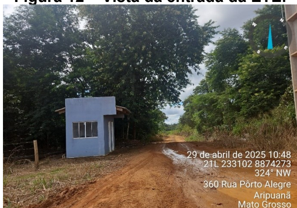
Figura 12 – Vista da entrada da ETE.
