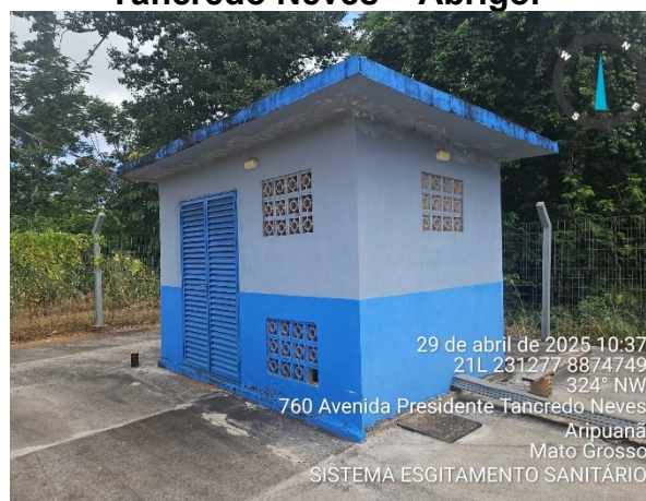
Figura 5 – EEE Av. Presidente Tancredo Neves – Abrigo.
