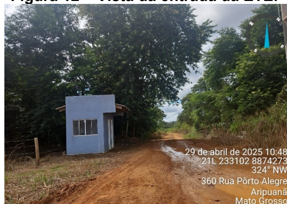
Figura 12 – Vista da entrada da ETE.
