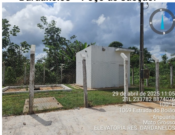
Figura 8 – EEE Residencial Dardanelos – Poço de sucção.
