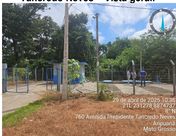
Figura 4 – EEE Av. Presidente Tancredo Neves – Vista geral.
