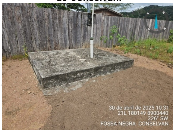
Figura 2 – Fossa existente – Distrito de Conselvan.
