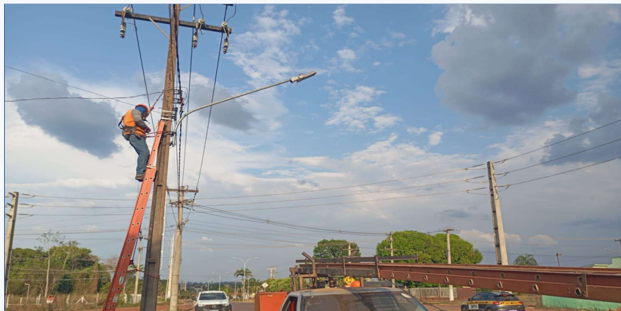
Latitude: -10.170682 Longitude: -59.456432 Elevação: 230.21±1 m Precisão: 11.6 m Tempo: 02-10-2024 16:26 Nota: Av Tancredo neves T1 Troca de luminária 150w preta, por led 145w programa M iluminado Ari
