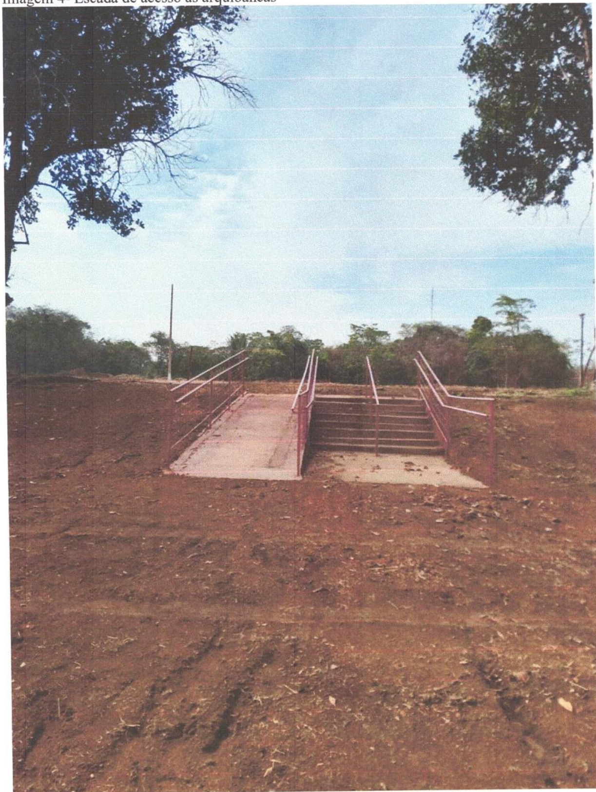
Imagem 4- Escada de acesso as arquibancas
