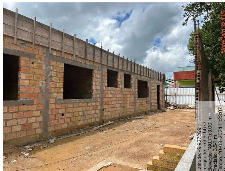
ITEM 6.0 – Alvenaria de vedação de blocos cerâmicos.
