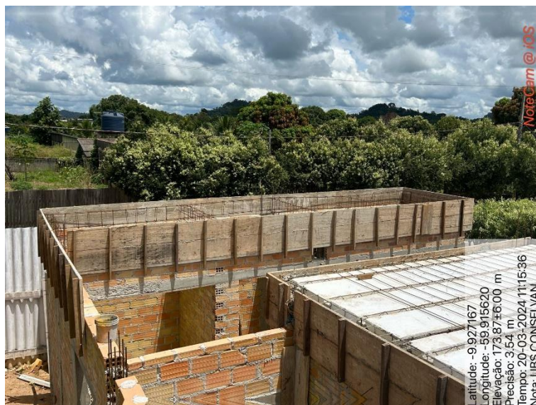
Armação e fôrmas de vigas
